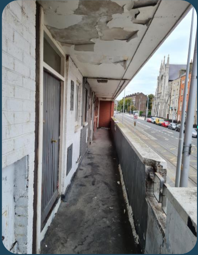
A. Site survey
